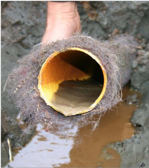
Billede 1: Mængden af sediment i drænrøret kan ifølge DHI anvendes til at beregne risikoen for tilstopning af drænrør som følge af dykkede dræn.
